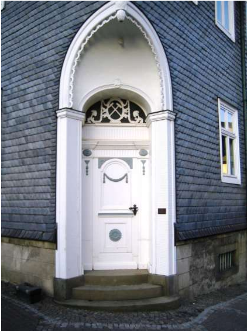
Abb. 2: Ansicht der Türanlage vor der Restaurierung
