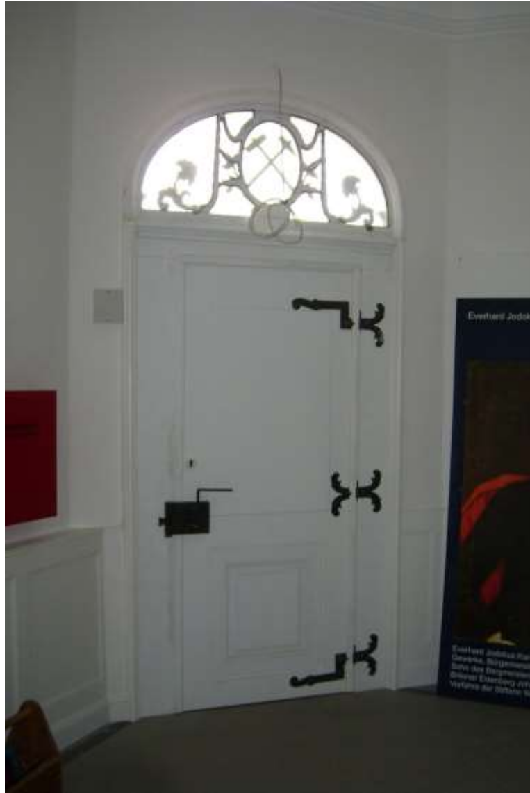
Abb. 67: Innenansicht der Tür nach der Restaurierung
