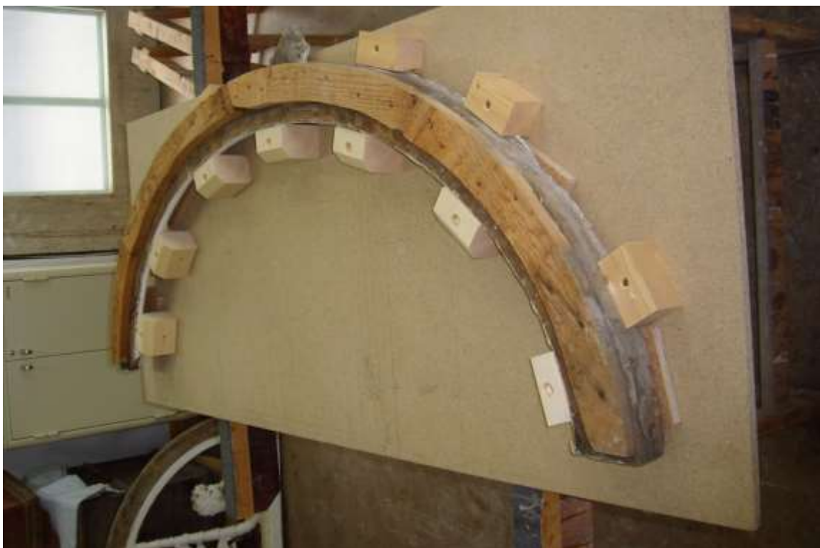
Abb. 7: Außenbekleidung mit aufgenagelter Verstärkung aus Fichte
