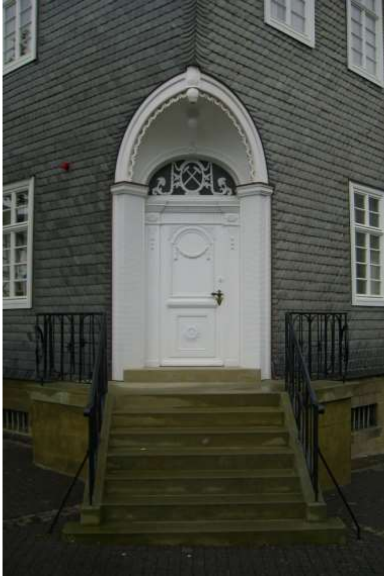
Abb. 66: Außenansicht der Tür nach der Restaurierung
