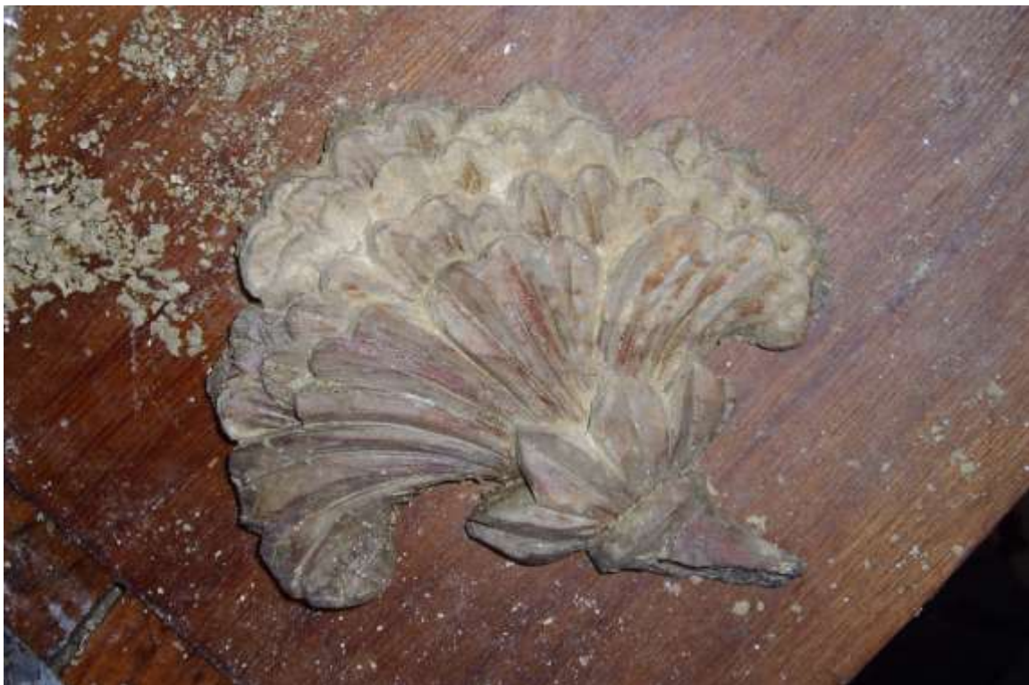
Abb. 51: Linke Blüte nach dem Entfernen der 8. Abbeizer-Schicht
