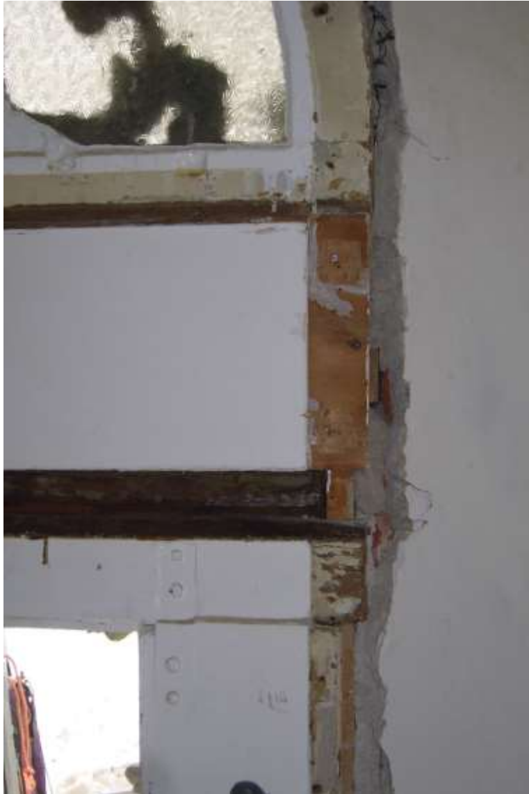
Abb. 5: Oberlicht, Zwischenstück und Blendrahmen während des Ausbaus
