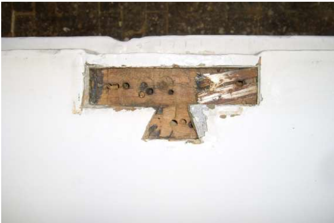
Abb. 9: Detail Schraubenlöcher unter dem Schließkloben
