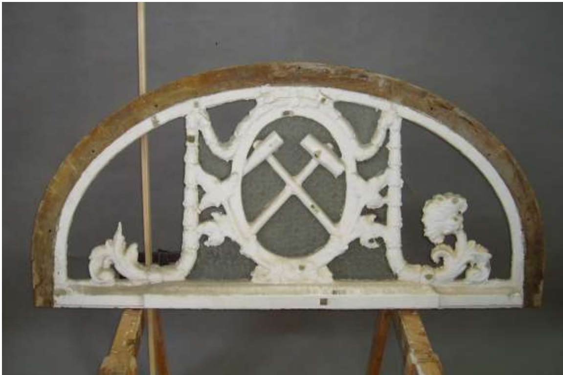
Abb. 19: Gesamtansicht des Oberlichts mit angelegten Farbfenstern
