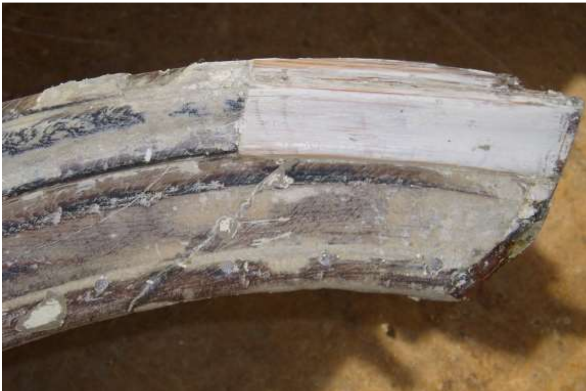
Abb. 13: Detail ergänztes Profil in Fichte Außenbekleidung
