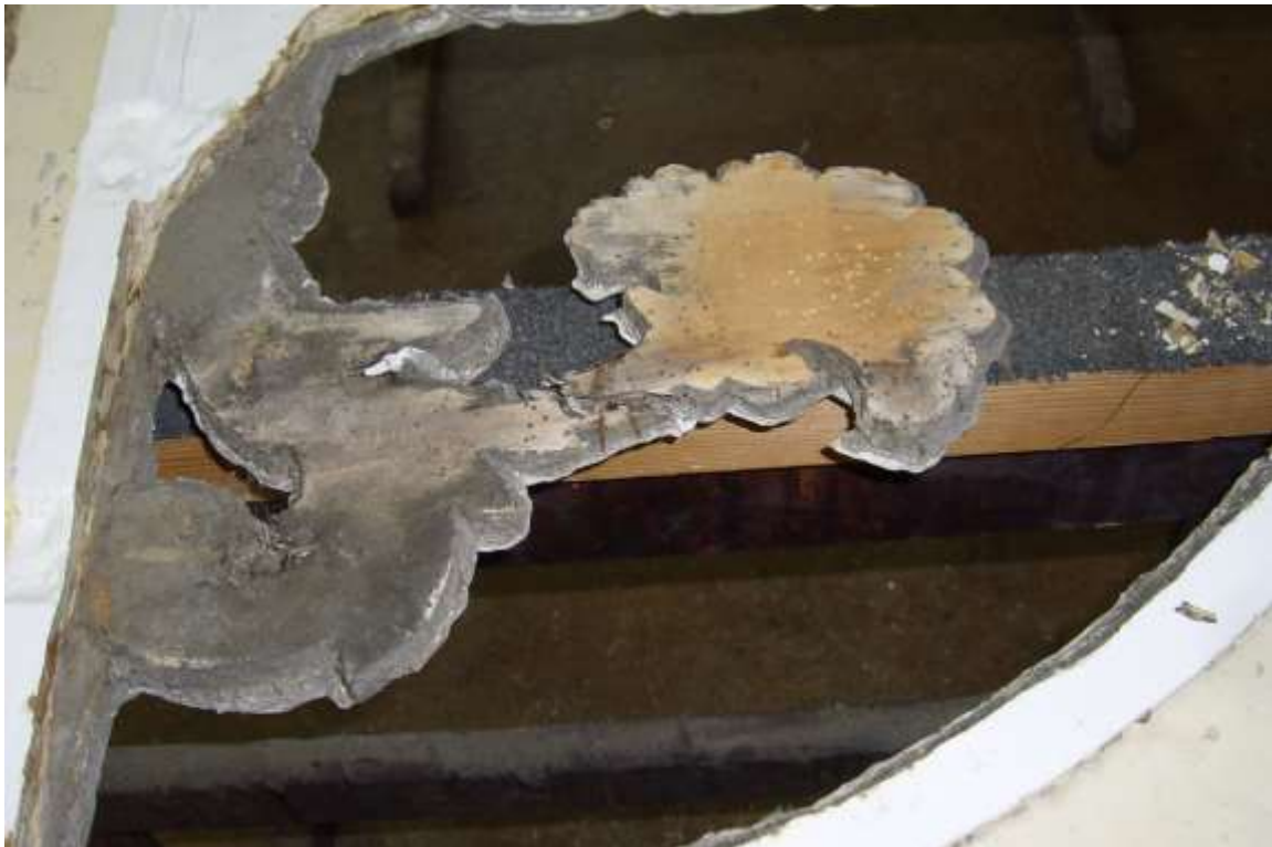
Abb. 14: Detail gebrochene Blüte nach dem Ausglasen
