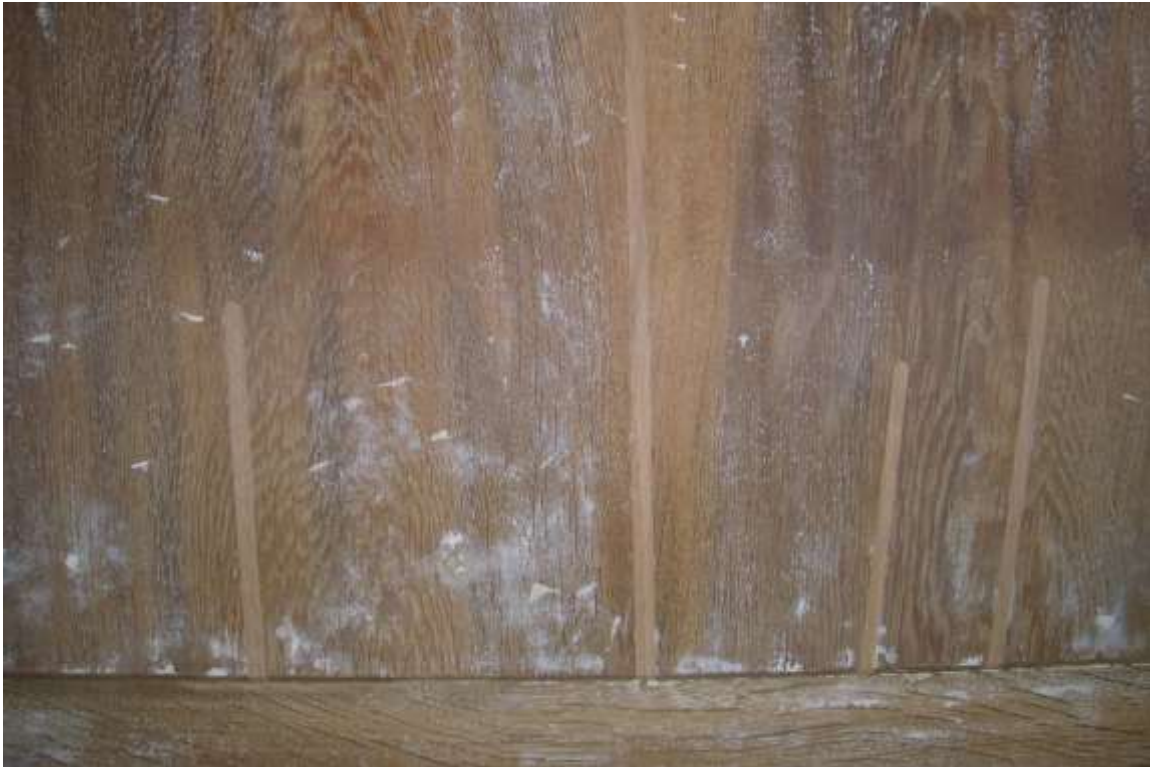
Abb. 63: Detail Unterkante obere Füllung, Innenseite
