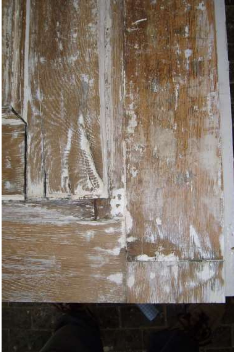
Abb. 36: Detail Türblatt unten rechts außen
