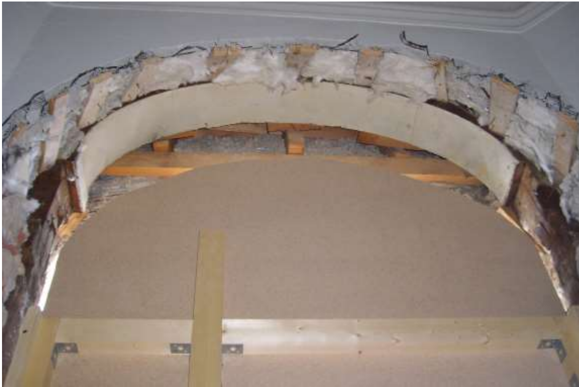
Abb. 6: Altes Türfutter und neue Gewölbekonstruktion während des Ausbaus
