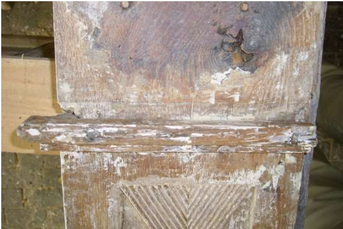
Abb. 12: Detail versetzte Profilleiste Blendrahmen oben rechts
