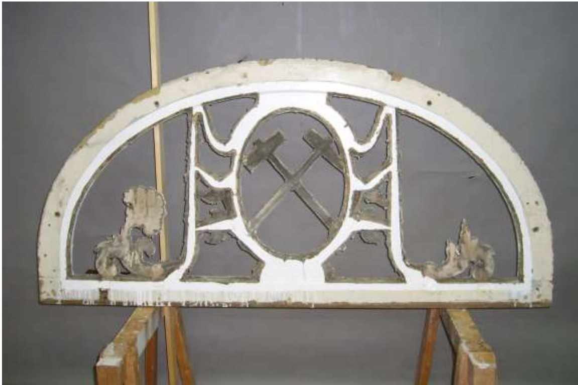
Abb. 42: Innenansicht Oberlicht nach dem Ausglasen
