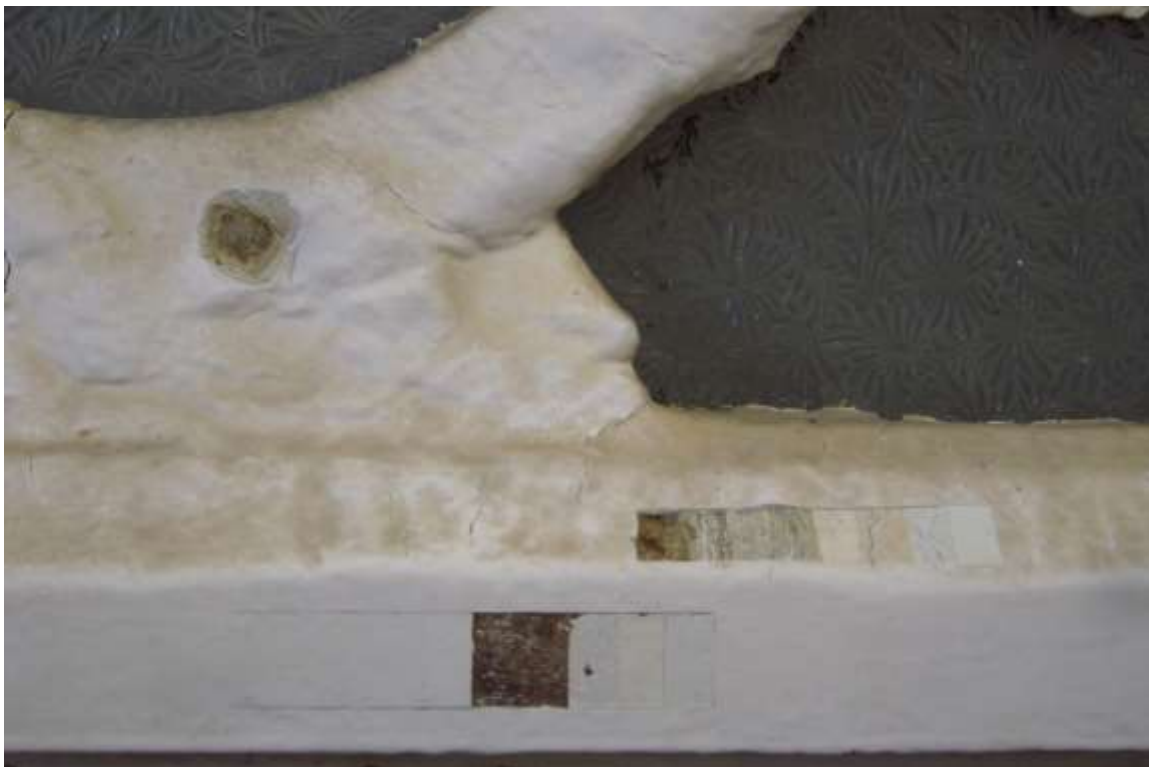
Abb. 18: Farbabtragungen auf der Unterkante des Oberlichtes
