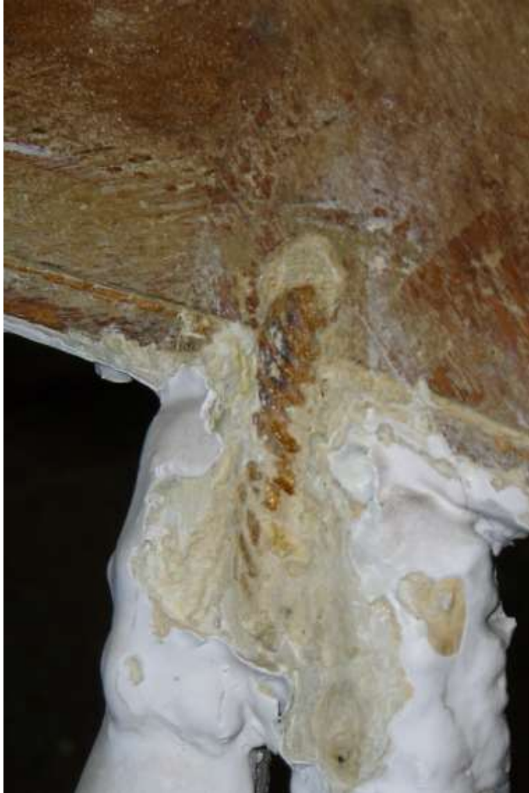
Abb. 26: Detail obere, rechte Aufhängung der Girlande in der Kordel Reste einer Vergoldung
