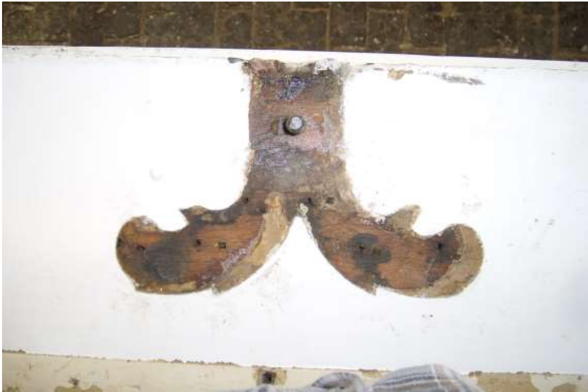
Abb. 8: Detail versetztes Scharnier auf dem Blendrahmen
