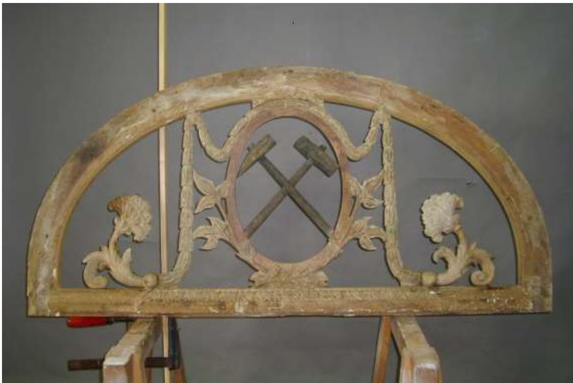
Abb. 53: Außenansicht des Oberlichts nach dem Abbeizen
