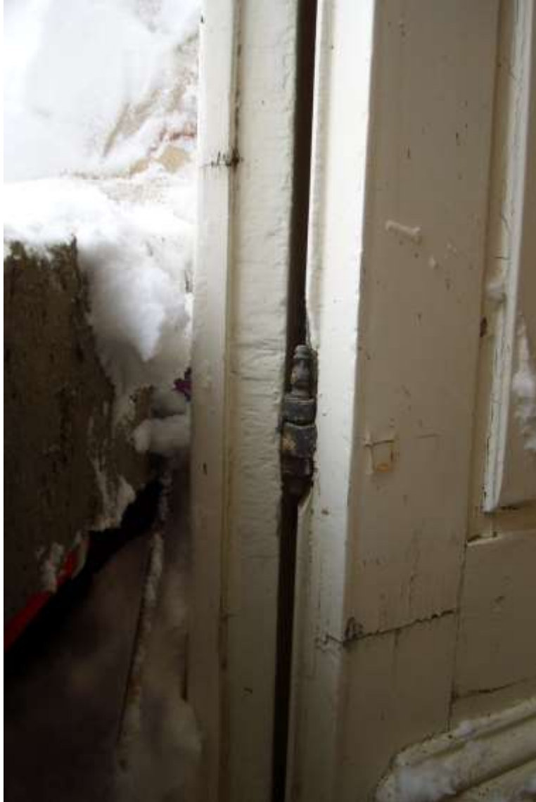
Abb. 3: Verlängerungen an Türblatt und Blendrahmen
