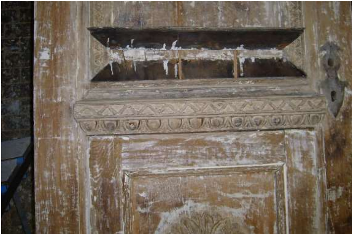
Abb. 31: Detail Türblatt außen
