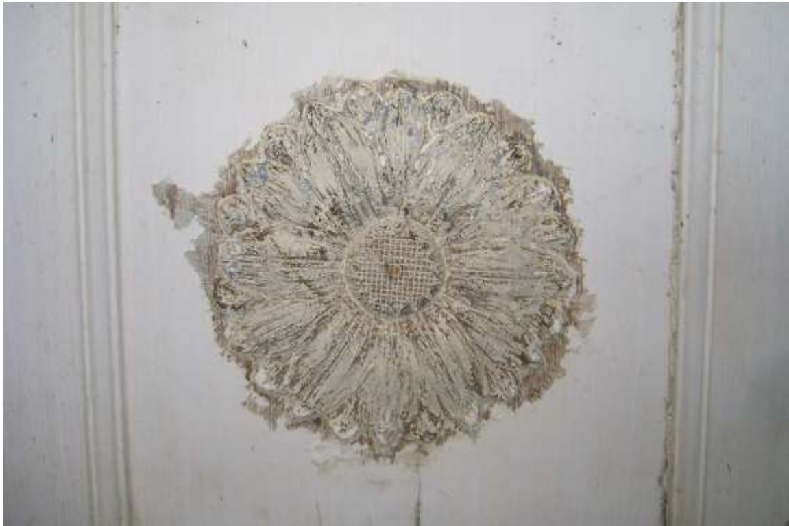
Abb. 16: Detail untere Türfüllung während des Abbeizens
