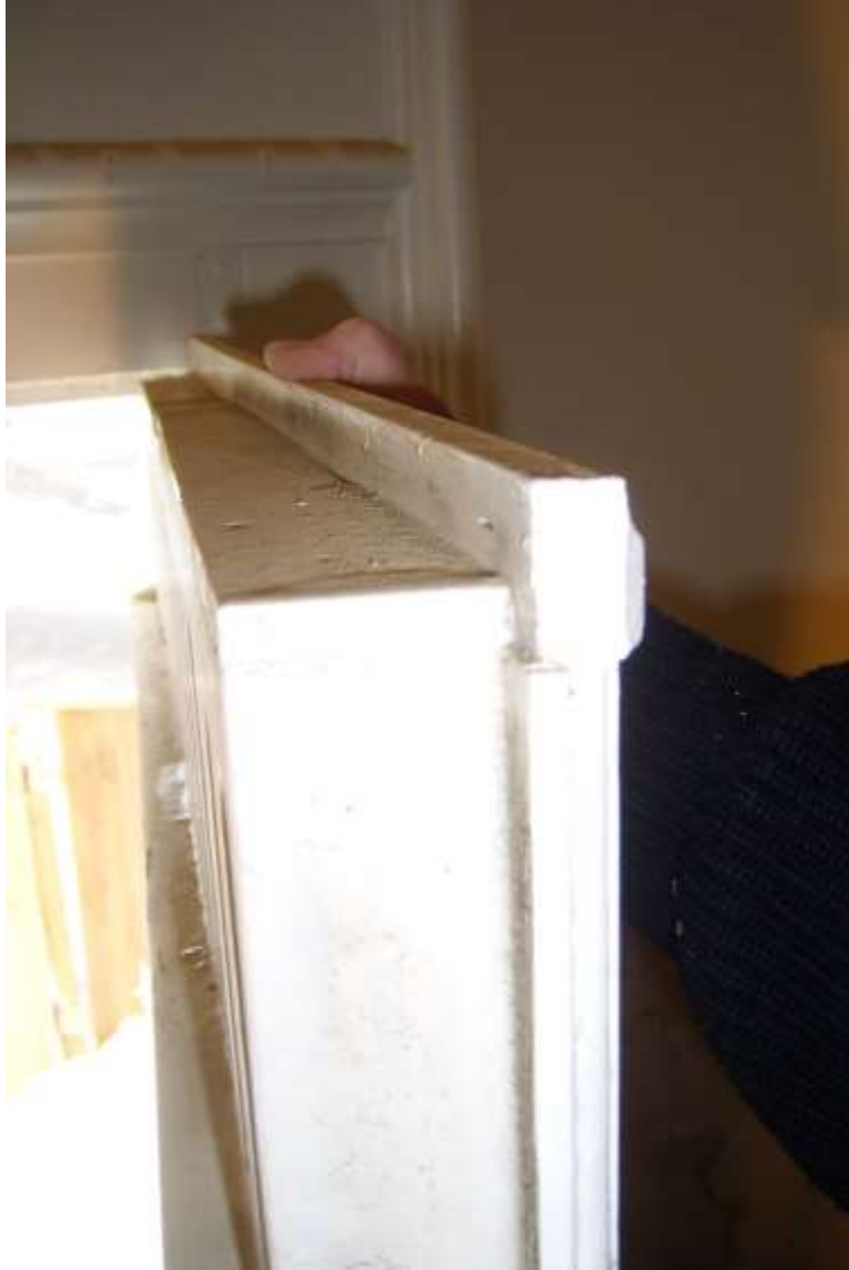
Abb. 11: Detail Leiste im oberen Falz und Schlagleisten
